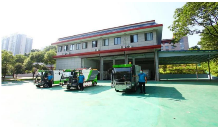
图 3-1 学校建设智能垃圾站
